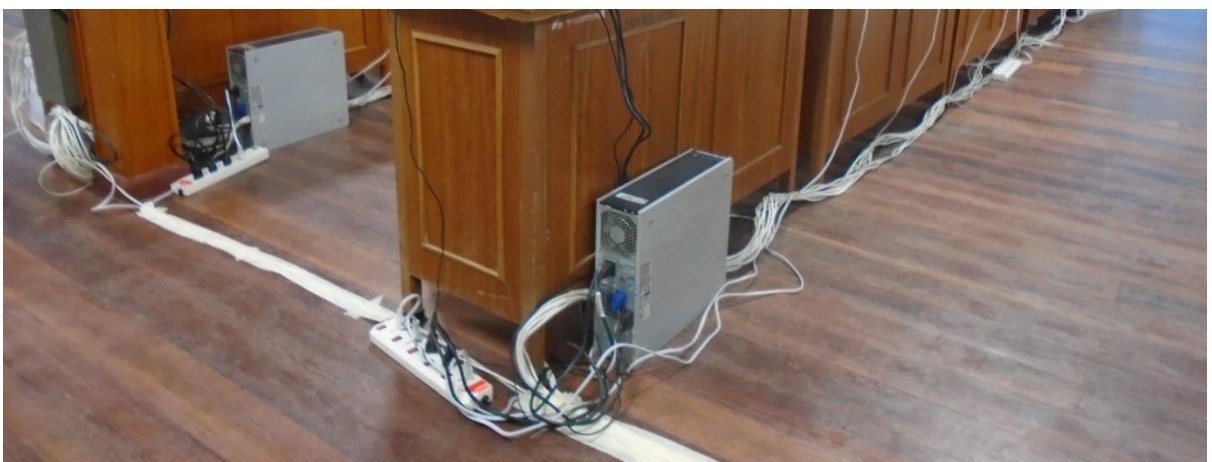
ติดตั้งระบบอินเทอร์เน็ต โดยการใช้ระบบสายแลน และระบบ wifi เพื่อความสะดวกในการอบรม
